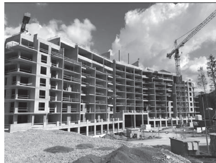
Obrázok č. 4: Výstavba nového hotelového komplexu Damián v Demänovskej Doline
