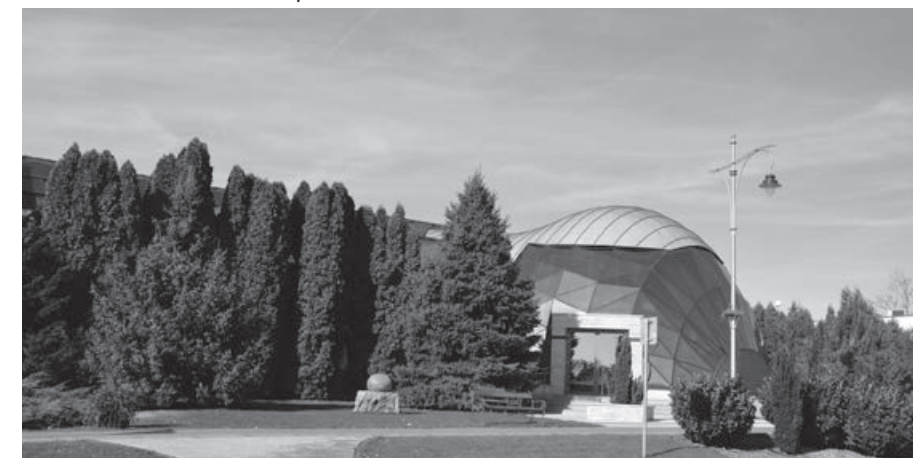
Obrázok č. 2: Malé Dvorníky, Moderné schodisko kultúrneho domu
